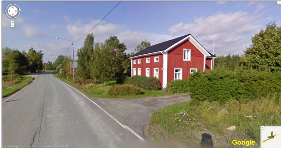
12 länteen. Viemäri tien oik. laitaa nurmikolla. Mitään ei tehtävissä eikä syytä tehdä.
